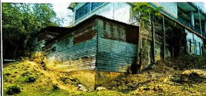
Foto 1: PARTE DE ATRÁS DE LA COCINA
