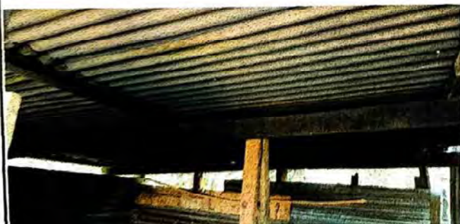
Foto 5: TECHO DE LA COCINA
